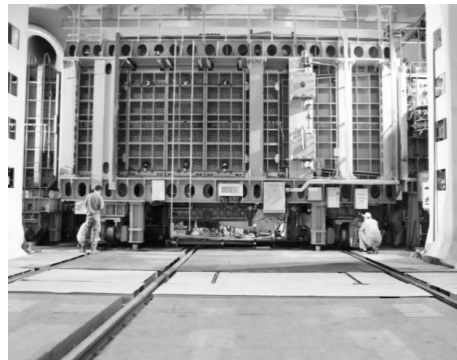
图 1 试验段更换
