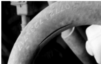
(b) 管道裂缝
