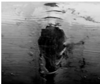
(c) 管道变形
