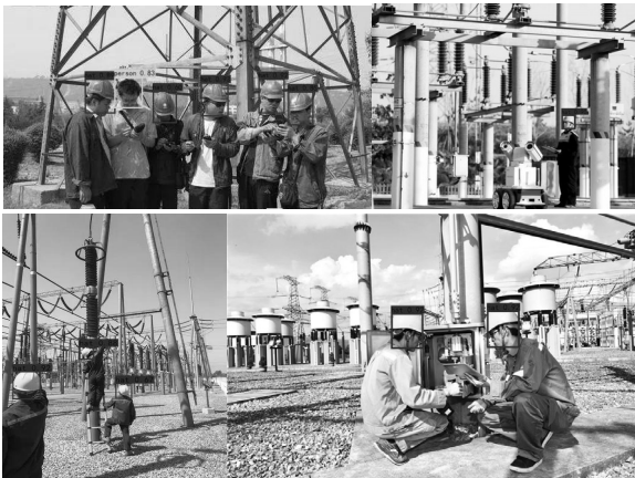
图 6 变电站巡检人员不规范佩戴安全帽检测部分结果展示
